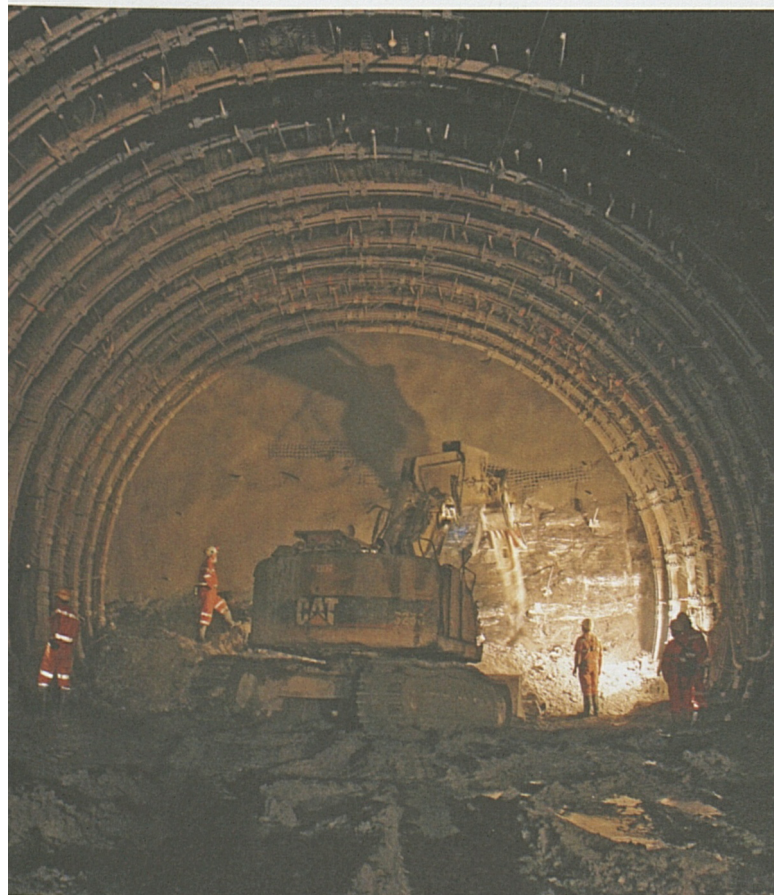
Südvortrieb: Mit Baggerschaufel und Abbauphammer in der Oströhre.
