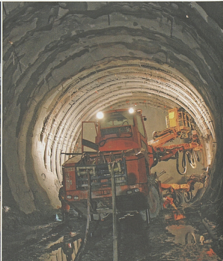
Südvortrieb: Fellsicherung in der Weströhre Richtung Süden.
