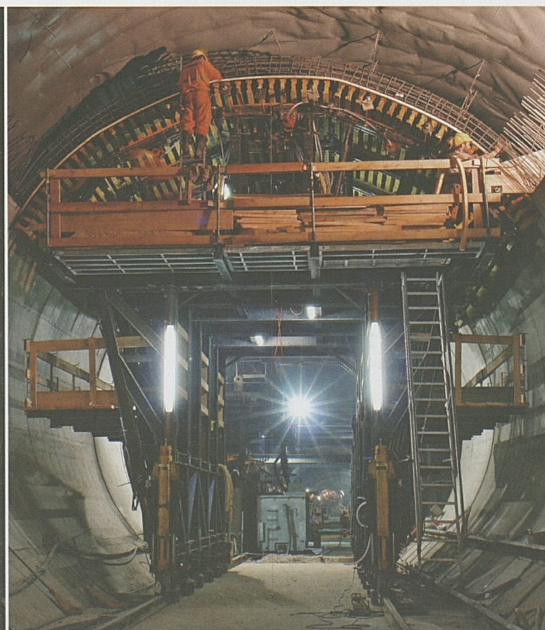
Betonarbeiten in der Multifunktionsstelle.
