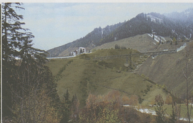
Fotomontage der Materialablagerung Val Bugnei mit der Erweiterung Val Bugnei Ost.
