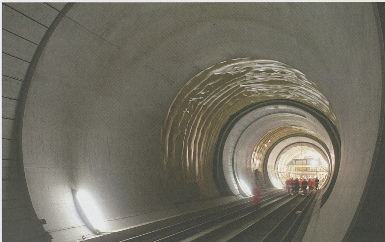
Die ersten Gewölbebetonetappen in der Multifunktionsstelle Sedrun, in den Lücken die Abdichtung gegen Bergwasser.
