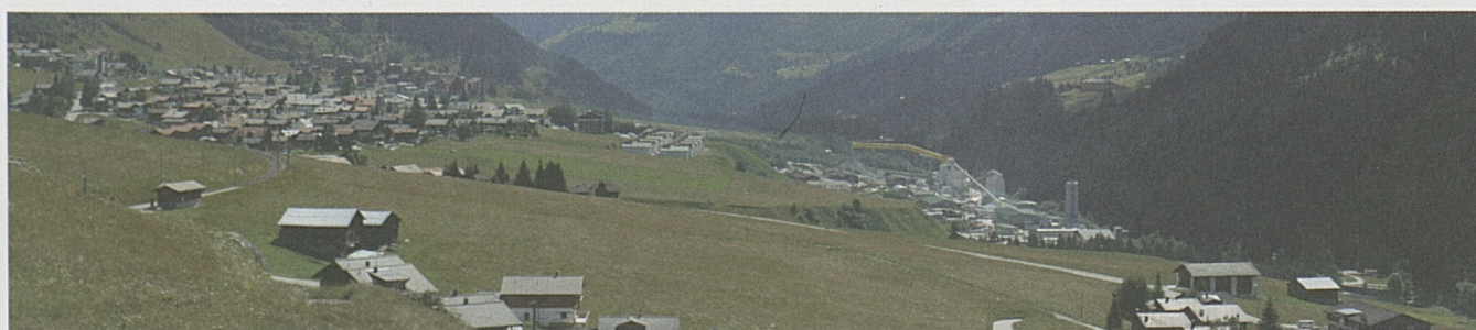
Dorf Sedrun mit Baustelle.
