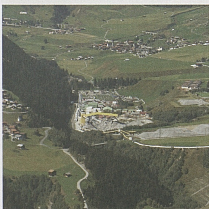
Tujetsch mit Dorf Sedrun und der Baustelle.
