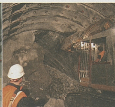
Faido – Durchschlag in der Weströhre der Multifunktionsstelle.
