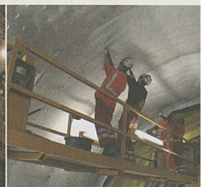
Bodio – Mineure beim Befestigen von Abdichtungsmatten in der Oströhre.
