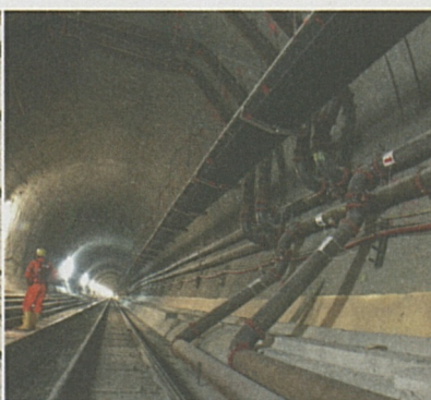
Amsteg – Blick in die Weströhre mit Förderband und Kühlwasserleitungen.
