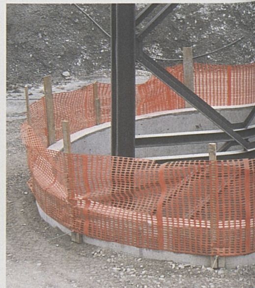
Stützpfiler der Eisenbahnbrücke im Val Bugnei.
