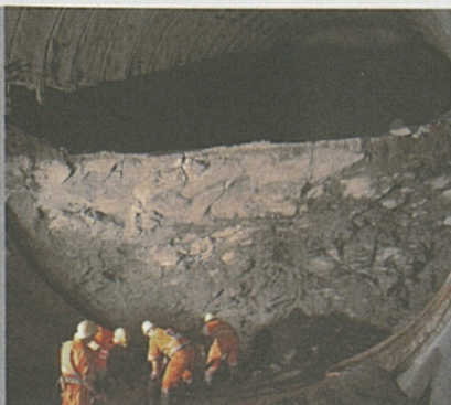
Komplexe Ausbruchsarbeiten in Faido.
