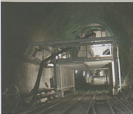
Oströhre des Gotthard-Basistunnels in Bodio.
