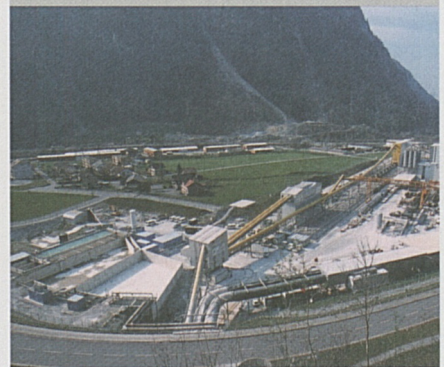
Installationsplatz Grund in Amsteg.
