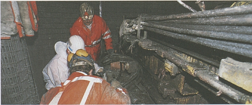
Mineure beim Ankerversetzen im Schacht II.
