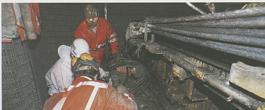
Mineure beim Ankerversetzen im Schacht II.
