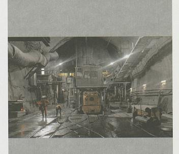
Mit der Schachtförderanlage können pro Tag 6350 Tonnen Ausbruchmaterial gefördert werden.
