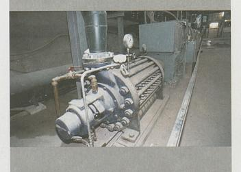
Mit acht Hochdruckpumpen wird das Bergwasser zum Schachtkopf gefördert.
