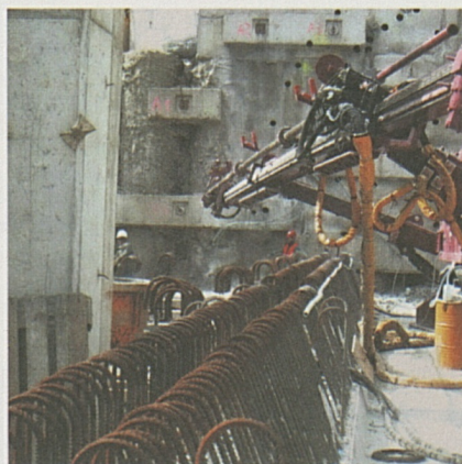
In Bodio laufen die Bohrarbeiten für den Rohrschirm im Bereich der Lockergesteinsstrecke auf Hochtouren.
