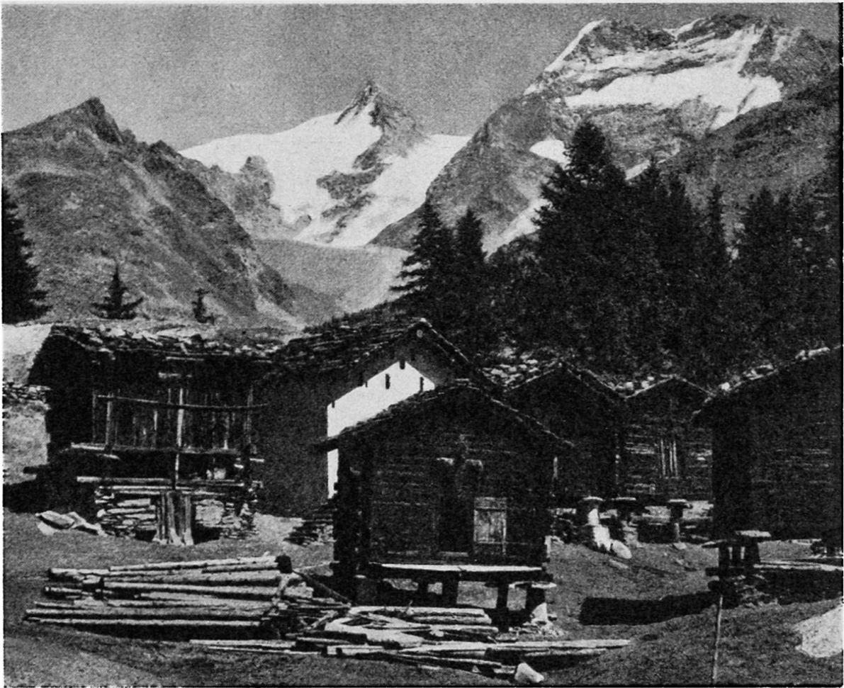
Fig. 2. Toits d'anselles maintenus par des pierres. Saas-Fee
