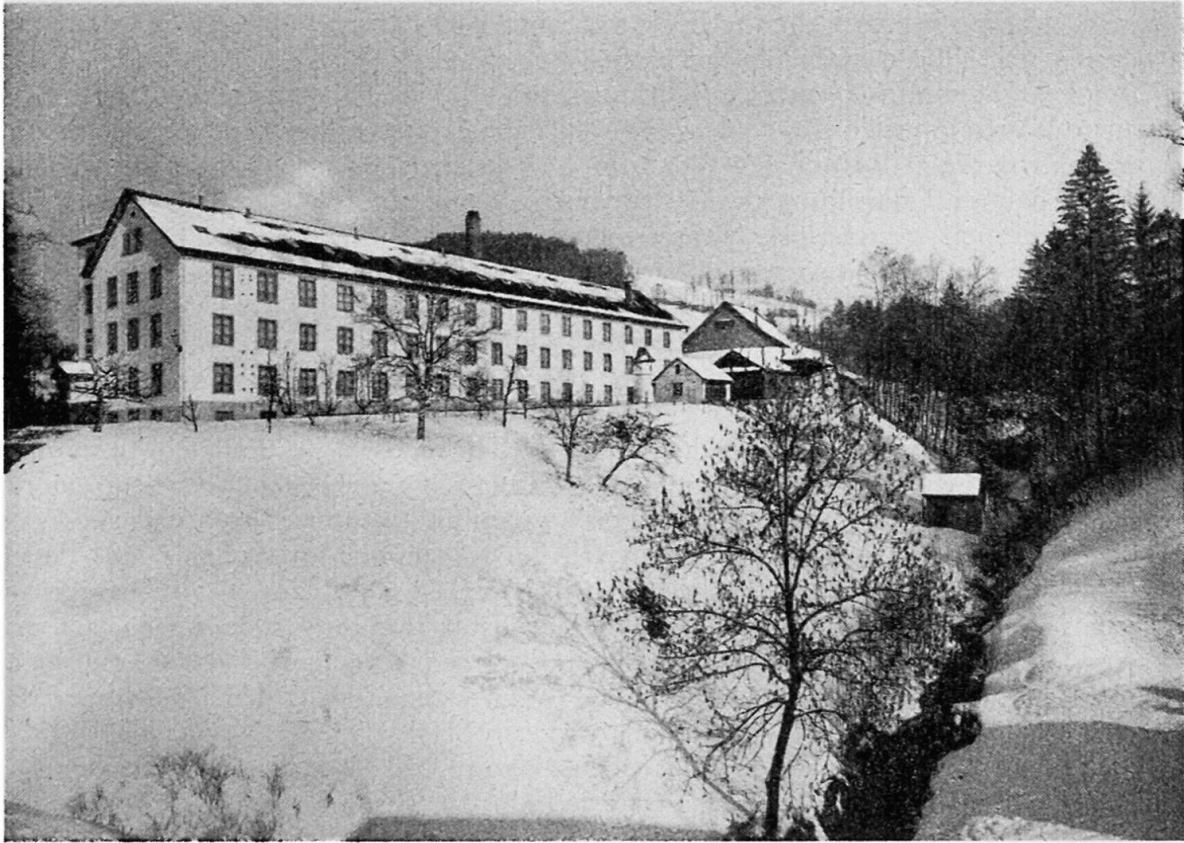
Abb. 3. Aelteste, 1858 eröffnete Baumwollweberei Bäretswil, die sogenannte «obere Fabrik». Rechts das Tobel des Kemptner Baches, dessen Wasser fast ganz durch die Fabrik ausgenutzt wird. Photo M. WEISS.
