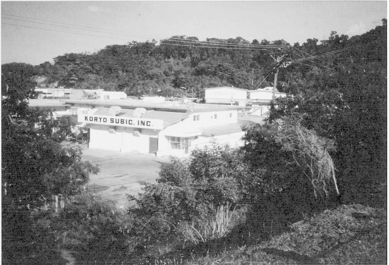
Abb. 2: Nachnutzung ehemaliger militärischer Gebäude in der Subic Bay Freeport Zone
