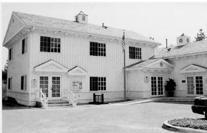
Abb. 5: Hidden Hills: Verwaltungsgebäude Hidden Hills: city hall Hidden Hills: mairie (Photo: N. GRILLON)
