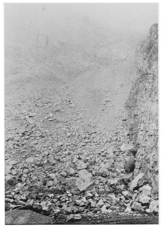
Abb. 4 Bergsturzmasse im Steinbruch, photographiert Anfang Februar 1974. Etwa 55 000 m³ Material sind hier liegengeblieben.
