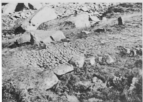
Abb. 13 Gotthard-Nordseite, Mäteliboden südlich Hospenthal (UR): Kopfsteinpflaster, vor 1820. Standort: 685 875/160 175/1790 m; Bildmitte: Az: 2000 A o/oo; LK: 1231.
