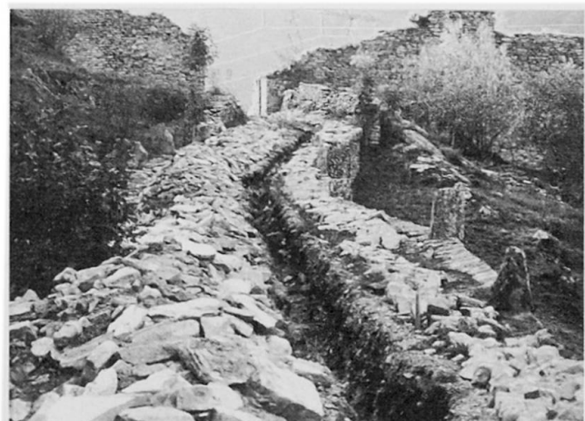
Abb. 8 Promontogno, Sperrung Castelmur (GR): Die Plästerung eines bedeutenden historischen Weges wird zur Verlegung eines Leitungskabels aufgebrochen. Standort: 763 500/134 200/900 m; Bildmitte: Az: 4600 A o/oo; LK: 1276.
