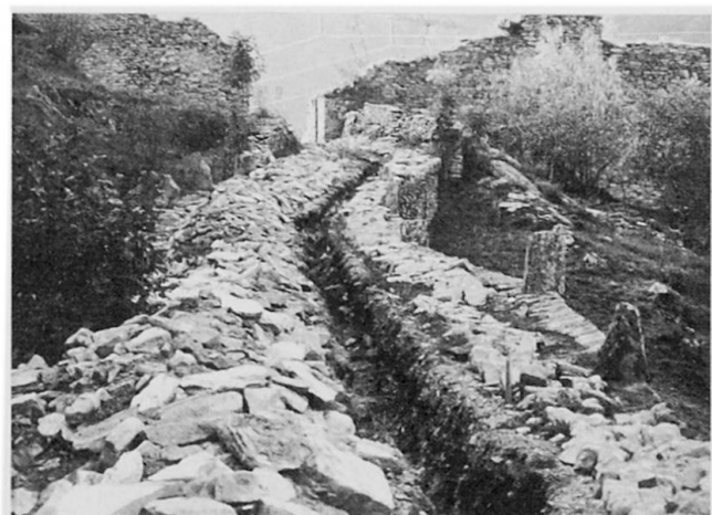
Abb. 8 Promontogno, Sperre Castelmur (GR): Die Plasterung eines bedeutenden historischen Weges wird zur Verlegung eines Leitungskabels aufgebrochen. Standort: 763 500/134 200/900 m; Bildmitte: Az: 4600 A o/oo; LK: 1276.
