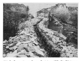
Abb. 8 Promontogno, Sperre Castelmur (GR): Die Plästerung eines bedeutenden historischen Weges wird zur Verlegung eines Leitungskabels aufgebrochen.
