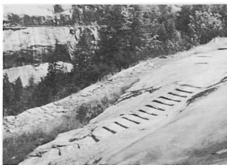
Abb. 14 Grimsel-Nordseite, Hälenplatte zwischen Handegg und Kurzentännlen (BE): Stufen im anstehenden Fels. Standort: 667 090/161 650/1510 m; Bildmitte: AZ: 1600 A o/oo; LK: 1230.
