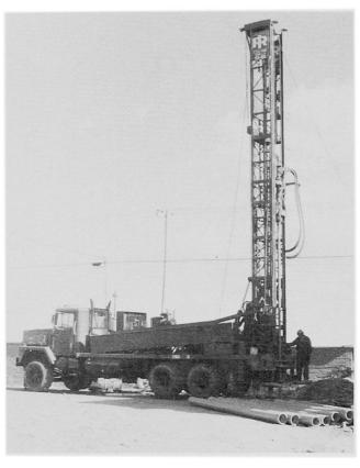
Abb. 4 Diese Bohrequipe von GEOBOL arbeitet hier auf dem Altiplano (77.5/84) und wird in ca. 70 m Tiefe Grundwasser erschließen.
