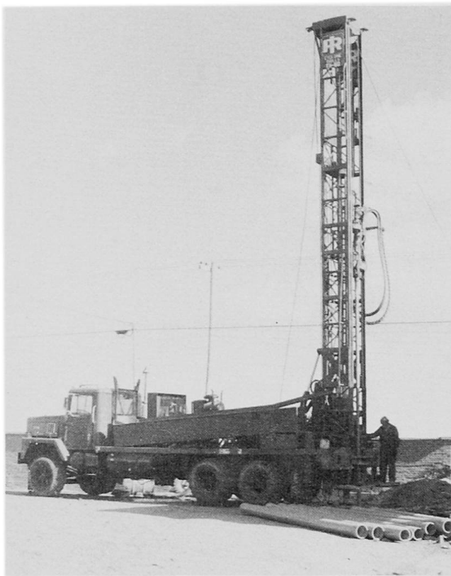
Abb. 4 Diese Bohreigep von GEOBOL arbeitet hier auf dem Altiplano (77.5/84) und wird in ca. 70 m Tiefe Grundwasser erschließen.
