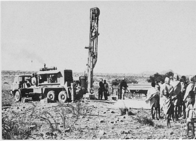
Abb.2: Einsatz einer Bohrmaschine in einer Höhe von 2200müM im Hochland der Tigre Provinz.
