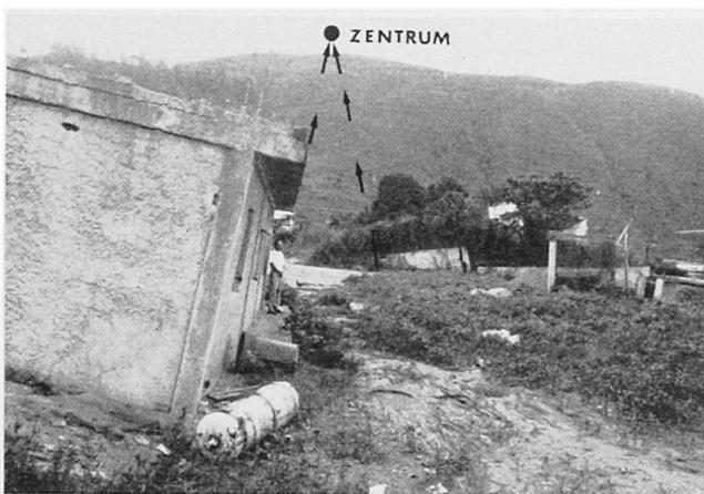
Bild 3 Rotationsförmige Sackung und Wirkung auf Bauten (bei Caracas, Venezuela).
