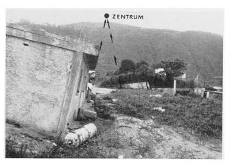
Bild 3 Rotationsförmige Sackung und Wirkung auf Bauten (bei Caracas, Venezuela).
