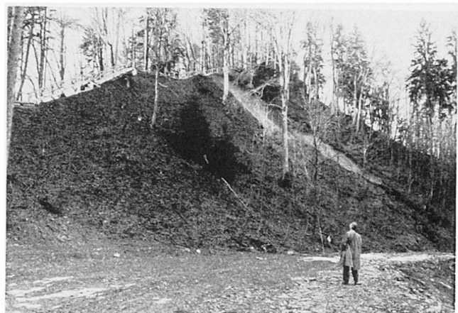
Bild 4 Durch Forststraße induzierter Bergrutsch (am Üetliberg-Kulm bei Zürich).
