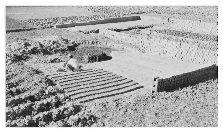
Abbildung 5. Rohmaterial für Ziegelherstellung. Das Abstechen des Reisfeldes ist im Text beschrieben. Der Arbeiter mischt an Ort und Stelle den Lehm mit Wasser, preßt die Masse in Formen und legt die Rohziegel zum Trocknen (Bildmitte) aus. Vorne rechts ein Brachfeld, welches Reis trug; links vorne Stück eines Feldes mit Winterkulturen. – Aufnahme HB März 1968
