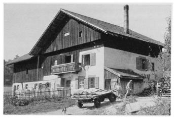
Photo 3. Illustration du passage de la ferme-pignon (bâtiment principal) à la ferme maltournée (étable récente). Ferme des Vieux-Prés sur Chézard
