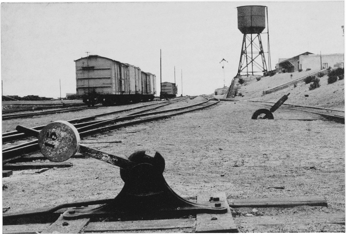
Abbildung 2. Hohe Wassertürme, einfache Unterkünfte für das Personal, davor ein kleines Blumenbeet, weite Abstellgeleise charakterisieren die Bahnstationen des Altiplano. Im Zahnradabschnitt müssen die ursprünglichen Zugskonvois in kleine Kompositionen aufgeteilt werden; Equipenwechsel werden vorgenommen. Station Puquios (km 112,5; 3728 m)
