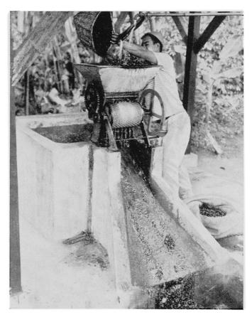
Abbildung 2. Despulpadora. Mit von Hand getriebenen Enthülsungsmaschinen werden die Kaffeebohnen von der fleischigen Umhüllung, der Pulpa, befreit
