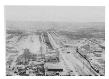
Abbildung 7. Trocknungsöfen bei Beni-Idir. Von den offenen Lagern (hinter den röhrenförmigen Öfen vorn links) gelangen die Phosphate in die Öfen und von dort in die Silos (ganz rechts im Bild). Rechts im Vordergrund wird ein Phosphatzug beladen. Photo O.C.P.
