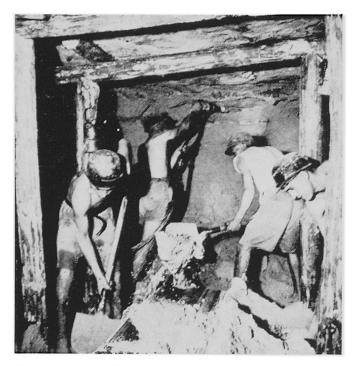
Abbildung 4. Abbau unter Tag in einer Mine bei Khouribga. Das Abbaugut wird mit Preßluftbohrern gelöst (Hintergrund) und nachher mit Schaufeln auf das Transportband (Vordergrund) geladen. Photo O.C.P.
