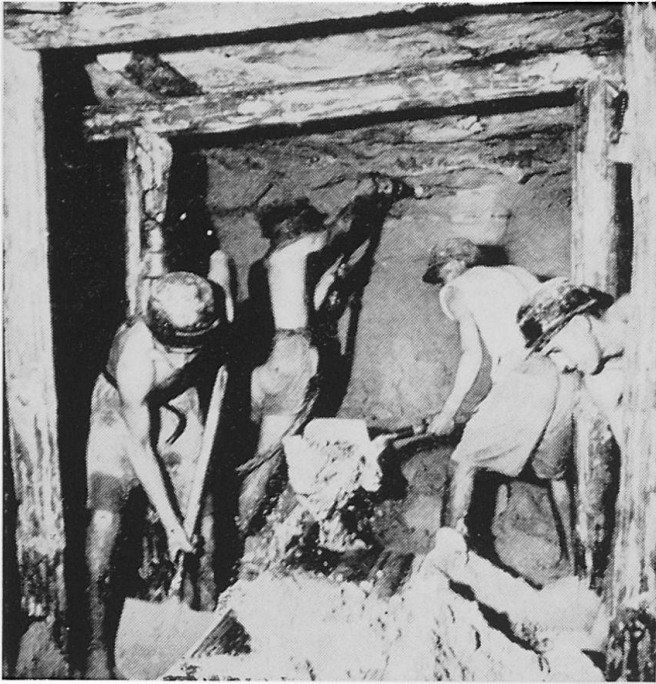
Abbildung 4. Abbau unter Tag in einer Mine bei Khouribga. Das Abbaugut wird mit Preßluftbohrern gelöst (Hintergrund) und nachher mit Schaufeln auf das Transportband (Vordergrund) geladen. Photo O.C.P.
