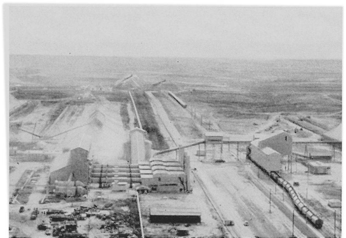
Abbildung 7. Trocknungsöfen bei Beni-Idir. Von den offenen Lagern (hinter den röhrenförmigen Öfen vorn links) gelangen die Phosphate in die Öfen und von dort in die Silos (ganz rechts im Bild). Rechts im Vordergrund wird ein Phosphatzug beladen. Photo O.C.P.
