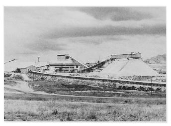
Abbildung 6. Wasch- und Zentrifugieranlagen von Kerkour-Rih. Über lange Transportbänder wandern die Phosphate von einer Verarbeitungsstufe zur andern. Photo Verfasser
