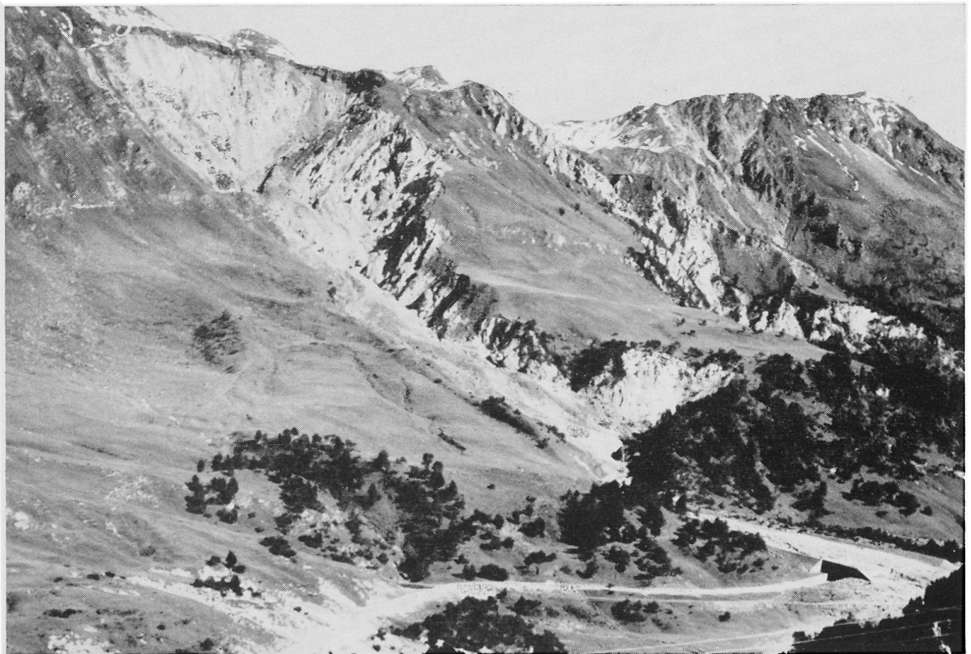
Abbildung 1. Vallone di Casaccia (Lukmanier), Wildbachtrichter und Schuttkegel, den die Paßstraße in einer Galerie quert
