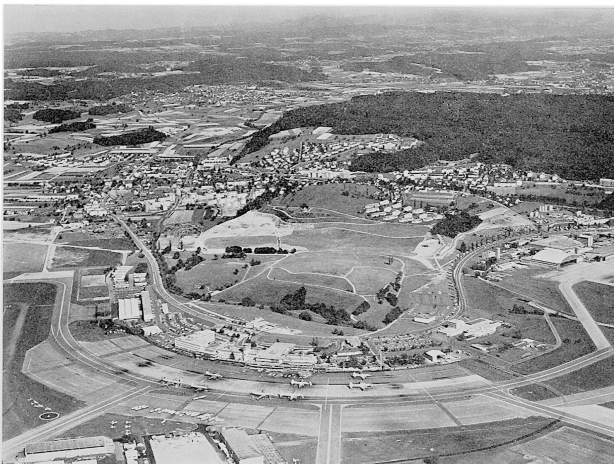
Fig. 3* Kloten vom Flughafen aus. Hinter dem Flughafen der Holberg, im Hintergrund links Bassersdorf und rechts Brüttisellen. (Comet-Photo)
