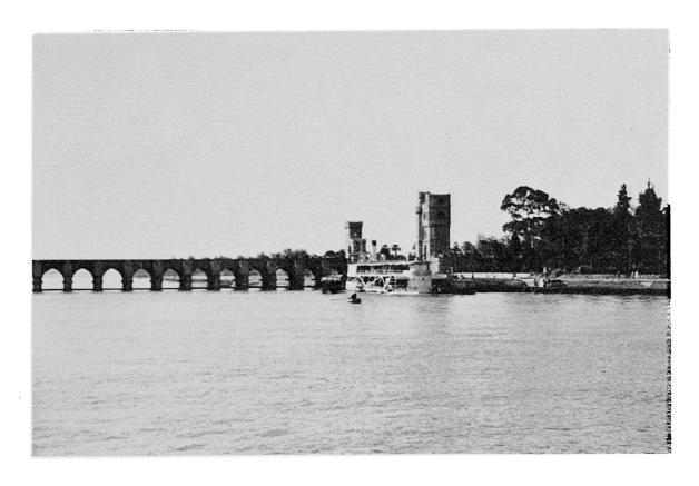
Abb. 3: Barrage du Nil. Der alte Damm regelt den Abfluß ins Delta.
