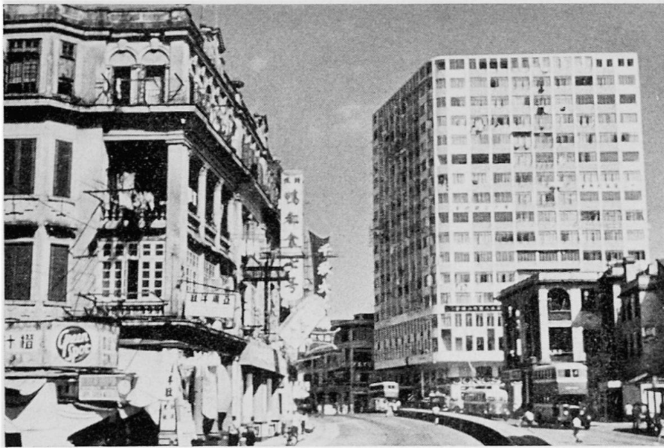
Fig. 4. Jordan Road in Kowloon. Nördlich des Taifunhafens quert sie in west-östlicher Richtung die Halbinsel. Modernste Hochbauten stehen neben älteren Wohn- und Geschäftshäusern.
