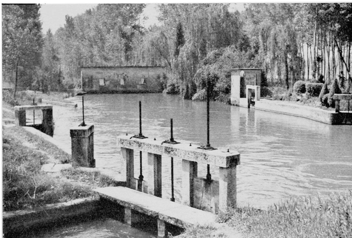
Wasserverteilung aus einem großen in kleine Kanäle zwischen Vercelli und Novara (Photo W. NELZ)
