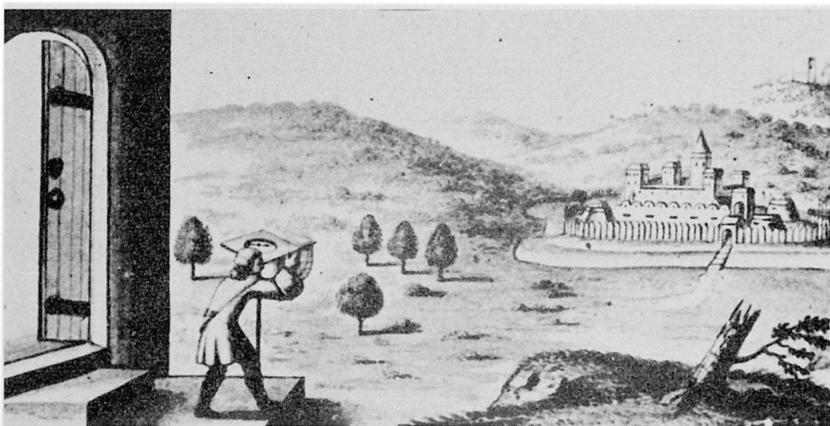
Fig. 4 Meyers Aufnahme im Feld bei Schloß Comburg. Bussole mit Quadrant als Instrumente
