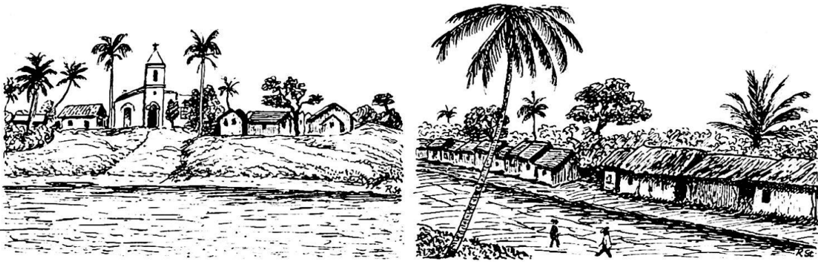
Caoioè, Hauptort im Tal des Rio Negro. Rechts die Hauptstraße
