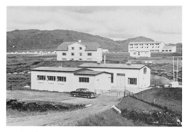
Abb. 2 Hauptpumpstation Reykir der Heißwasserversorgung von Reykjavik. Von hier aus wird das gesammelte Heißwasser durch die Überlandleitung nach der Stadt befördert.
