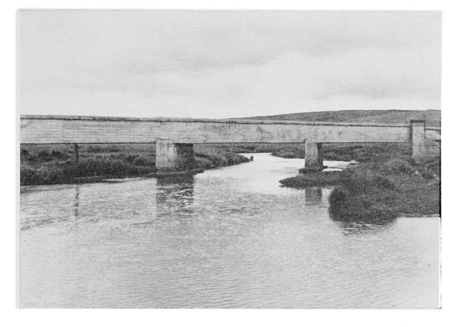
Abb. 3: Die Heißwasserleitung quert als moderner Aquaedukt einen Fluß. Täglich fließen rund 30 000 m³ Heißwasser durch den Leitungsquerschnitt.
