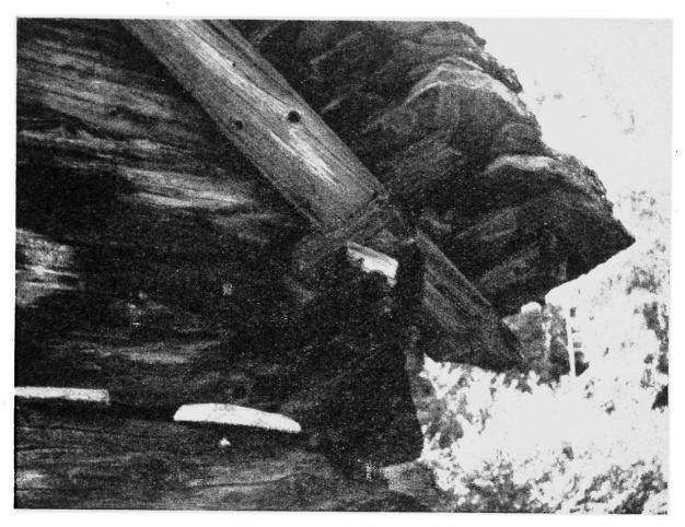
Abb. 35 Die "Kerbkonstruktion"
