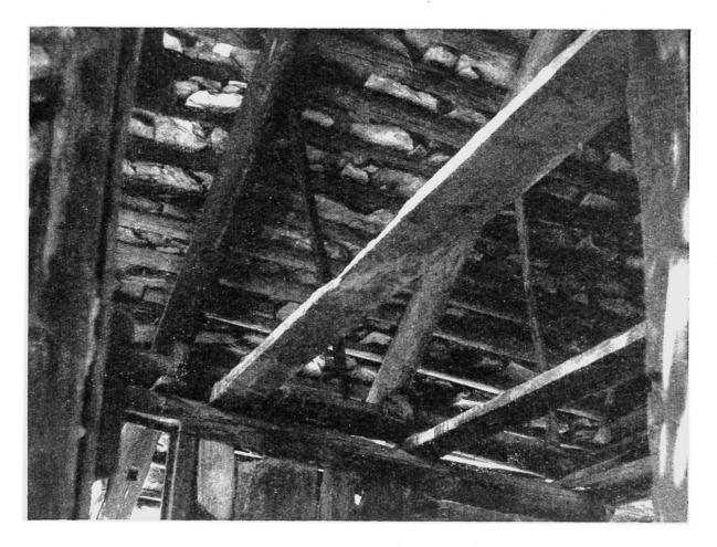
Abb. 34 Die "Zapfenkonstruktion"
