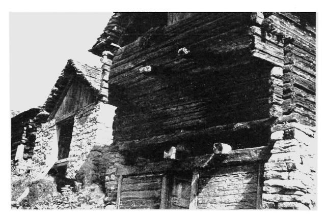
Abb. 31 Alter, gehobener Gurinerstadel im Verderr. Über dem Mittelstützel ist die Gefügelücke für die ehemaligen Dresch-Tennenbretter sichtbar
