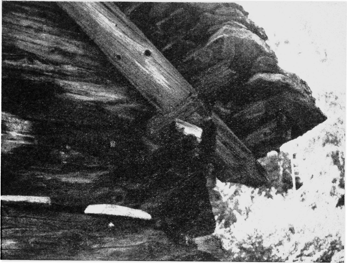
Abb. 35 Die „Kerbkonstruktion“
