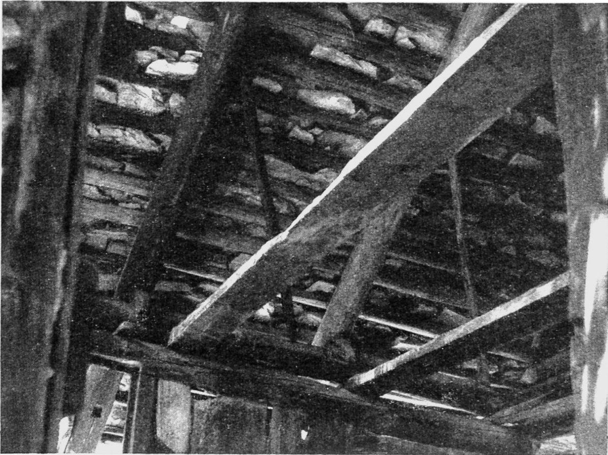
Abb. 34 Die „Zapfenkonstruktion“
