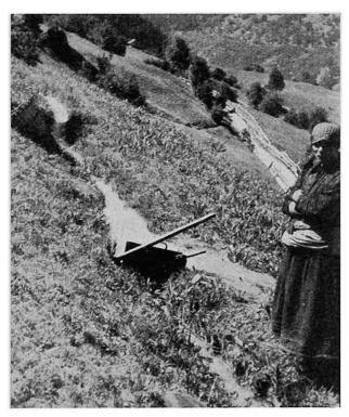
Abb. 4. In der aus dem Turtmanntal kommenden Suone von Ergisch hat die Wächterin das Wasserbrett eingeschlagen und damit das Wasser auf die Wiese rechts abgeleitet. Photo: R. PFISTER.
