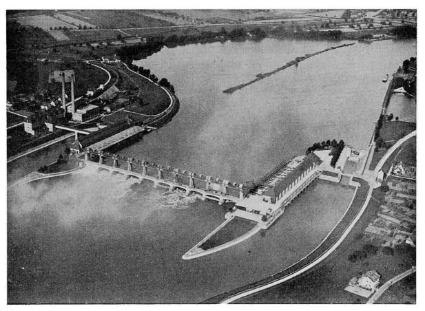
Abb. 7. Rheinkraftwerk Augst-Wyhlen als Typus eines großen Niederdruckwerkes (maximale Spitzenleistung: 42000 kW). Stauwehr mit Schützen; Zentrale links auf deutschem Boden, Zentrale rechts auf schweizerischem Boden; Unterwasserkanal mit Schiffsschleuse; Siedlungen und Gärten der Belegschaft. Photo Swissair.
