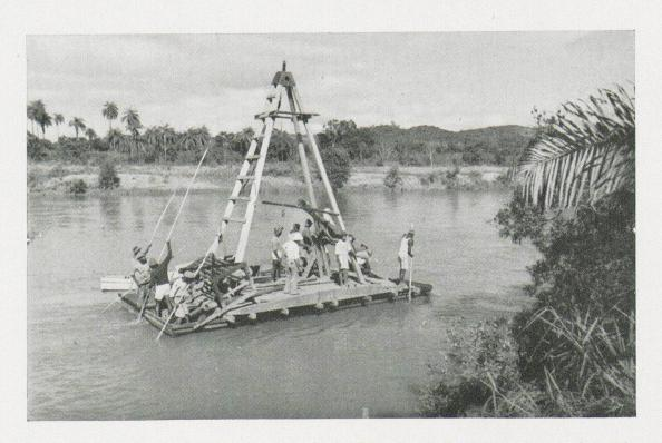
Abb. 12. Rio das Velhas. Unterhalb Sabará. Auf der Suche nach goldführenden Schottern; Bohrgestänge auf einem Floß.
