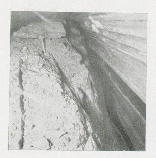
Abb. 11. Ausgebrochene und verschobene Gesteinsplatten. Blitzlicht.
