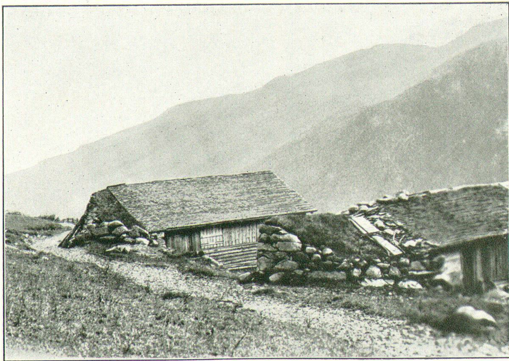
Abb. 11. Keilmauer als Lawinenschutz bei Scharinas.
