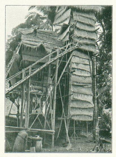
Abb. 1. Ein im Bau besindlicher Verbrennungsturm (wadah).
