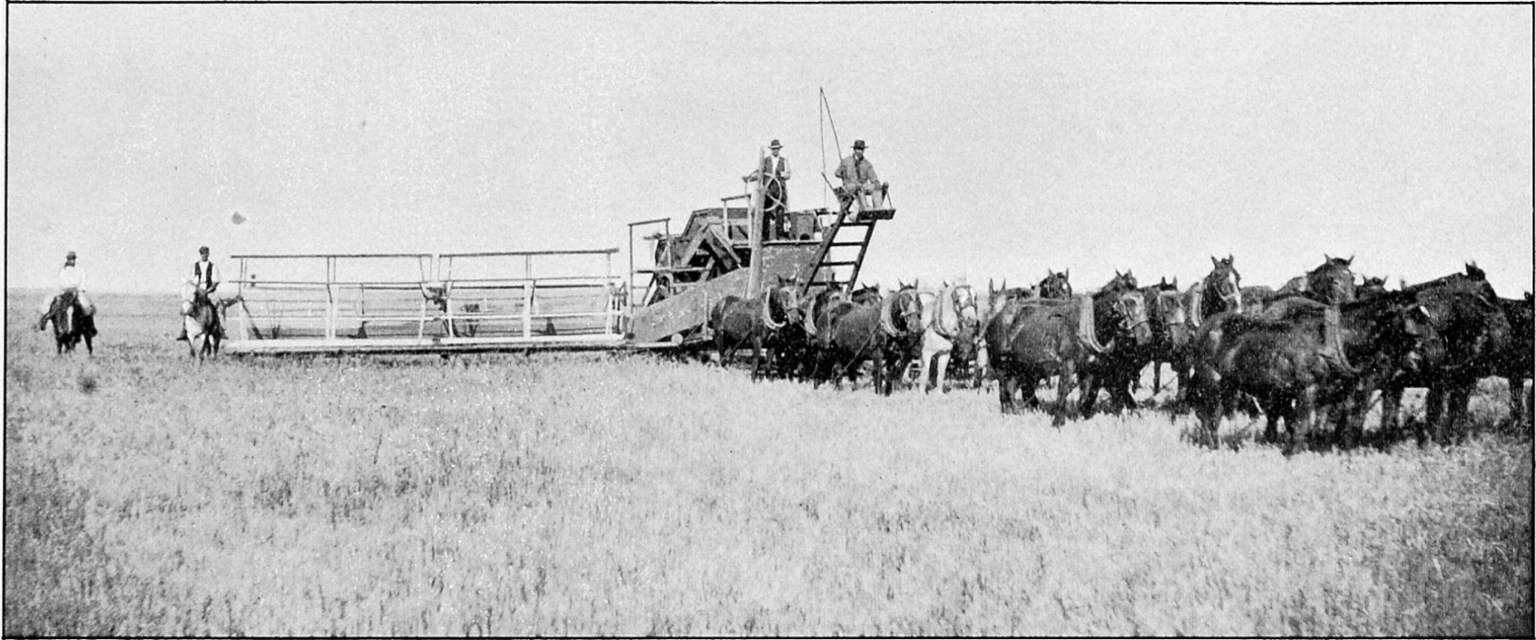
Zollinger'sche Schneide-Dresch- oder „Ernte“-Maschine. Die Maschine liefert das geschnittene Getreide auch sofort in Säcken gedroschen.
