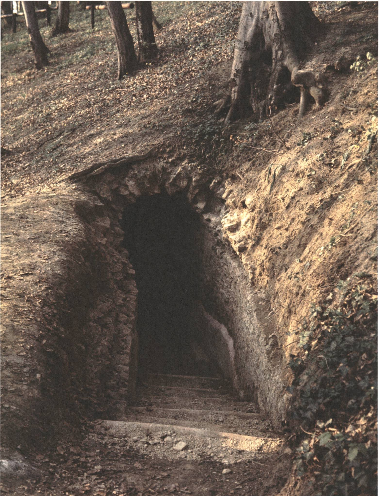
[8] Südlicher Einstieg zum begehbaren Abschnitt der römischen Wasserleitung im Wölferhölzli bei Füllinsdorf. Wasser- und Abwasserleitungen sowie unterirdische Gewölbe der römischen Stadt Augusta Raurica wurden später zum Gegenstand verschiedener zum Teil abenteuerlicher Sagen. Foto 1969.
