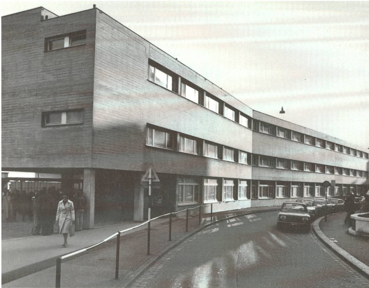
Abb. 14: «Aus der Tiefe des Steinenbachgässleins» – in den Jahren 1959 bis 1961 wurde das neue Schulhaus der FAS, der sogenannte Hangbau und heutiges Gebäude B, erstellt. Architekt war B. Weis.
