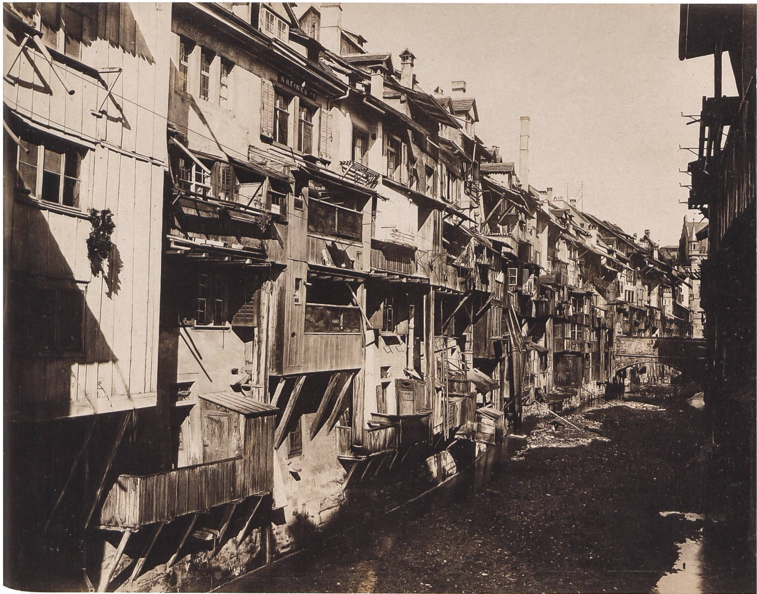
Abb. 25 Linkes Ufer des Birsigbettes zwischen Barfüsserplatz und Pfluggässlein (Fotografie vor 1900).
