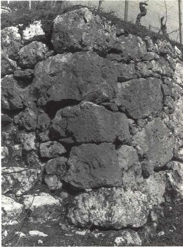
Abb. 29: Klusertal bei Aesch, alte Terrassenmauer im Rebge- lände, aufgeführt aus Steinen der nahen, im Erdbe- ben zerfallenen Burgen.
