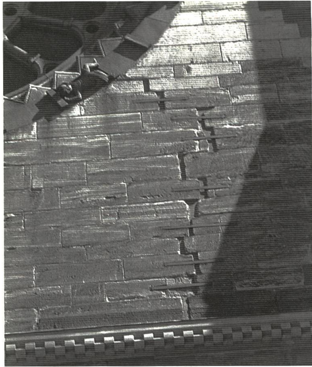
Abb. 16: Basler Münster, nördliches Querschiff. Verklammerte Risse unterhalb des Glücksrades, vermutlich beim Erdbeben entstanden.
