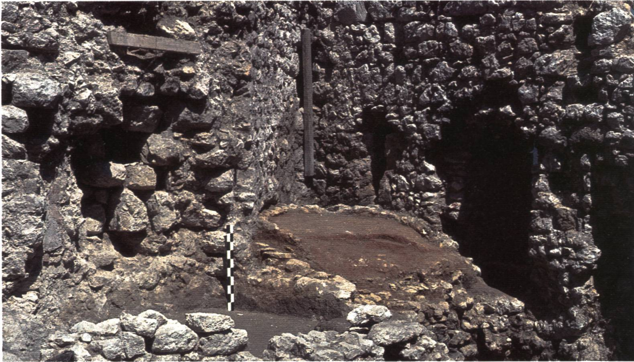
Abb. 30: Burgruine Löwenburg, Gemeinde Pleigne, Inneres der Hauptburg. Spuren der Umgestaltung nach 1356. Rechts erneuerter Backofen, links stehengelassener Teil des runden Hauptturmes.
