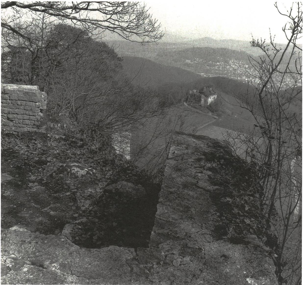
Abb. 8: Schauenburgflue, im Vordergrund Mauerreste eines gallo-römischen Tempels. Ecke vermutlich 1356 mit dem Fels abgestürzt. Im Hintergrund rechts Neu-Schauenburg.
