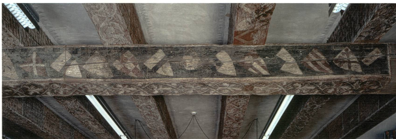
Abb. 13 a–f Der Wappenbalken im ersten Obergeschoss wurde als Unterzug wiedereingefügt, nachdem er bei der Restaurierung von 1966–70 dreiteilig zersägt gefunden wurde.
