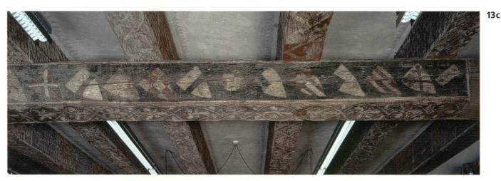
**Abb. 13 a–f** Der Wappenbalken im ersten Obergeschoss wurde als Unterzug wiedereingefügt, nachdem er bei der Restaurierung von 1966–70 dreiteilig zersägt gefunden wurde.
