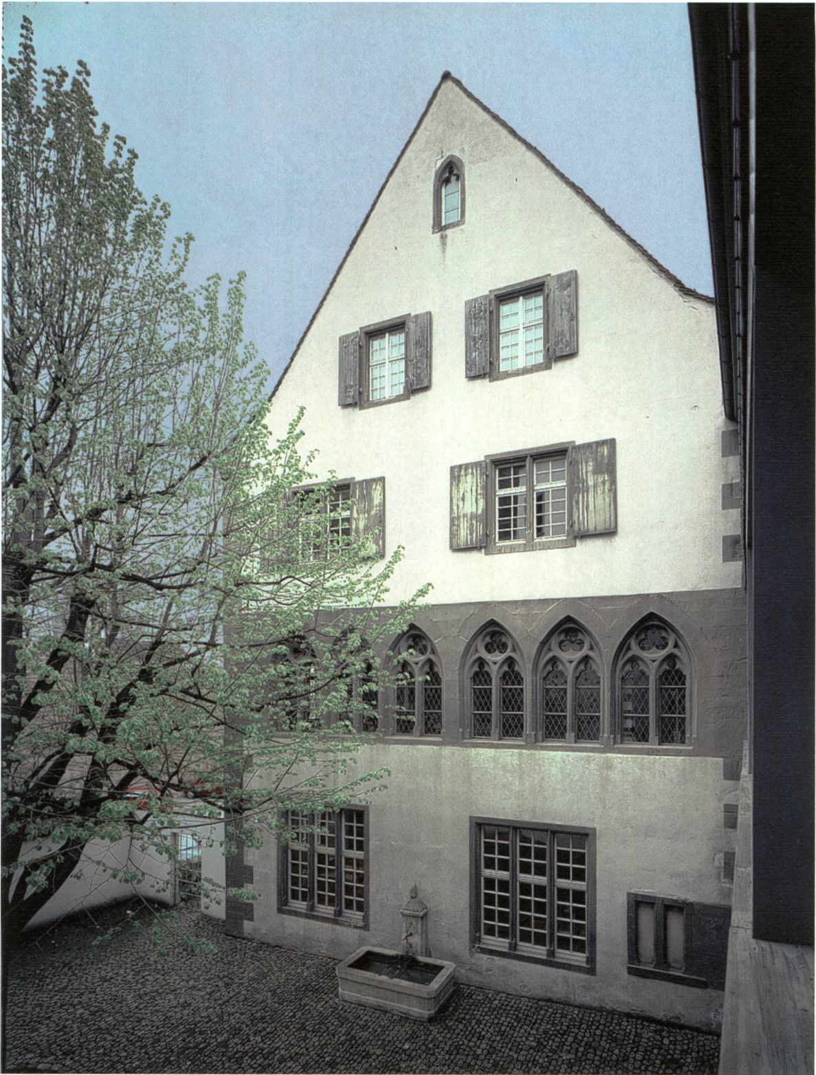
Abb. 4 Die giebelseitige Front mit den spitzbogigen Fenstern ist eine architektonische Besonderheit des «Schönen Hauses».
