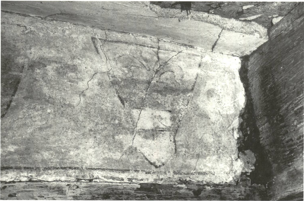
Festsaal im Erdgeschoss. Die Wandabschnitte zwischen den Balkenköpfen waren ursprünglich mit einem Wappenfries dekoriert. Heute nicht mehr erhalten ist das Wappen der von Hertenberg .
