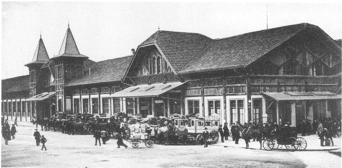
Abb. 46: Der provisorische Bahnhof an der Güterstrasse (1902–1907) auf einer Postkarte.
