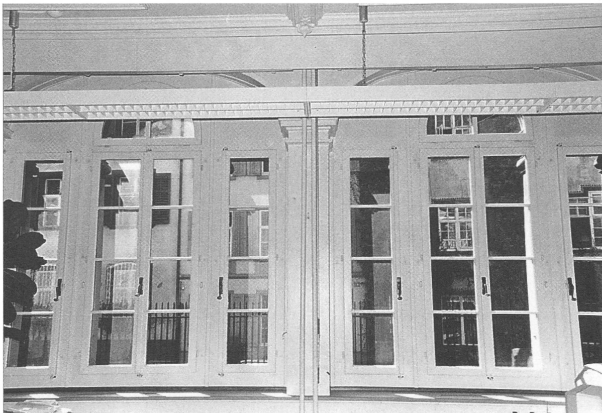
Abb. 21 «Spiesshof», Renaissancebau, 1. Obergeschoss, Pfeiler und Gewände der Serliana-Fenster
