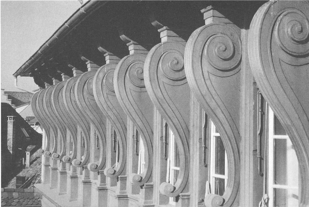
Abb. 35 «Spiesshof», Renaissancebau, Konsolenreihe des 3. Obergeschosses
