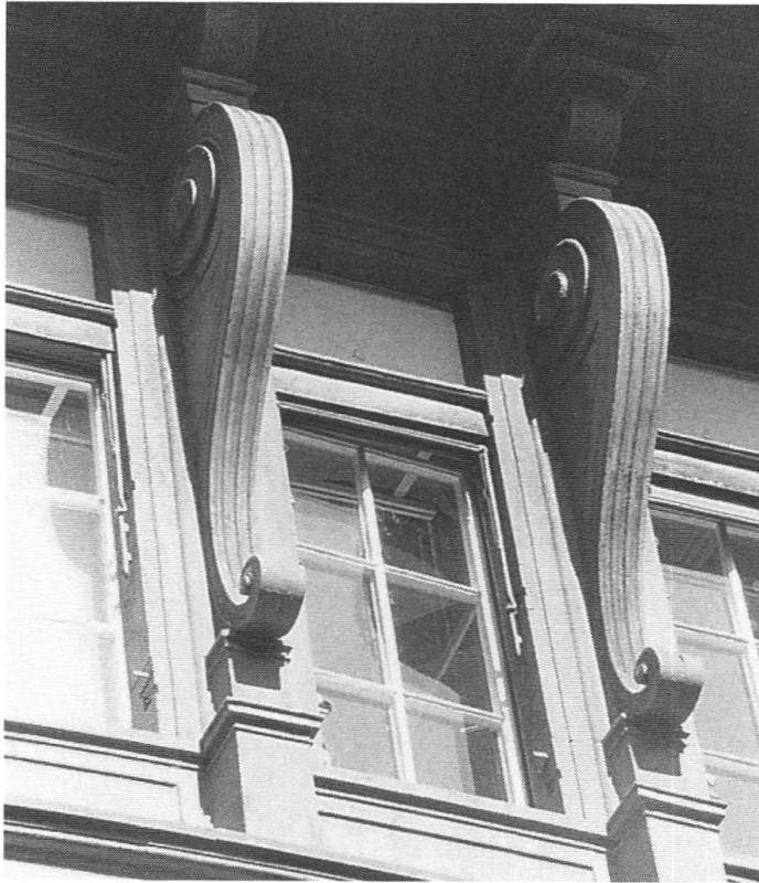
Abb. 19 «Spiesshof», Renaissancebau, 3. Obergeschoss, Fenster mit Volutenkonsolen
