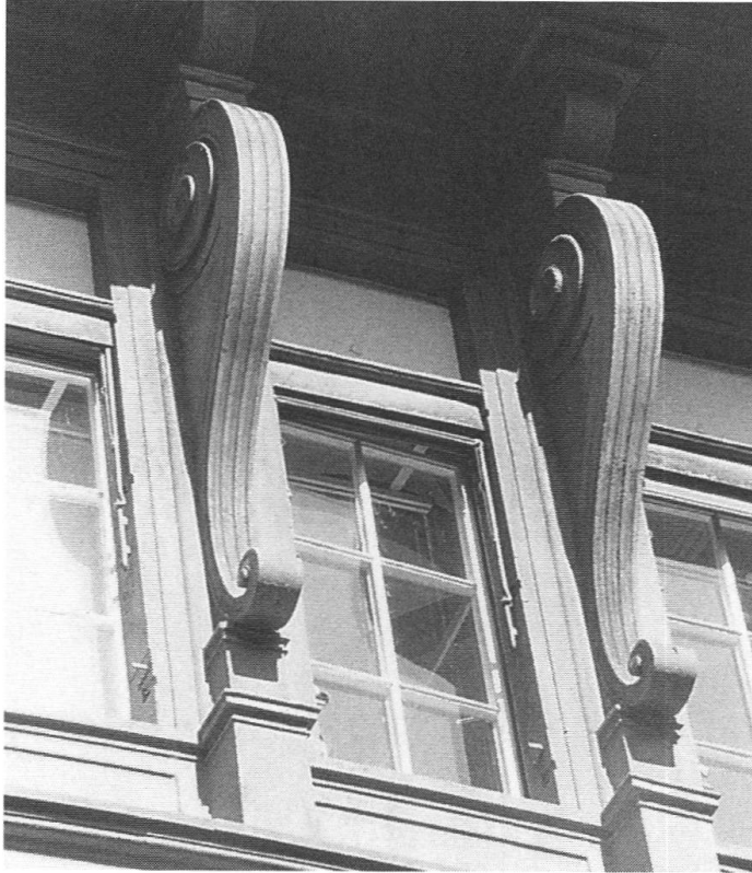
Abb. 19 «Spiesshof», Renaissancebau, 3. Obergeschoss, Fenster mit Volutenkonsolen
