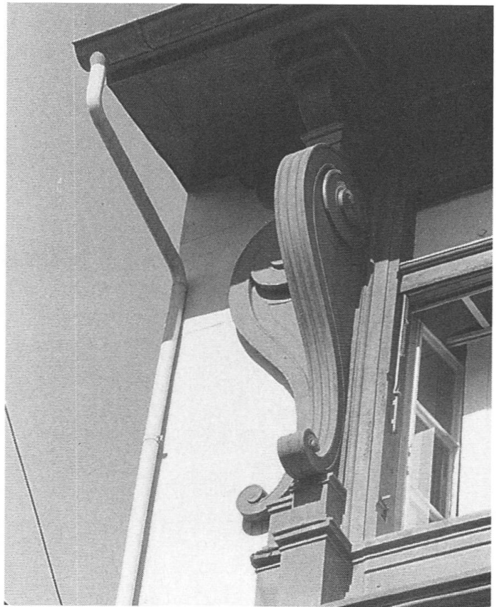
Abb. 19 «Spiesshof», Renaissancebau, 3. Obergeschoss, Fenster mit Volutenkonsolen
