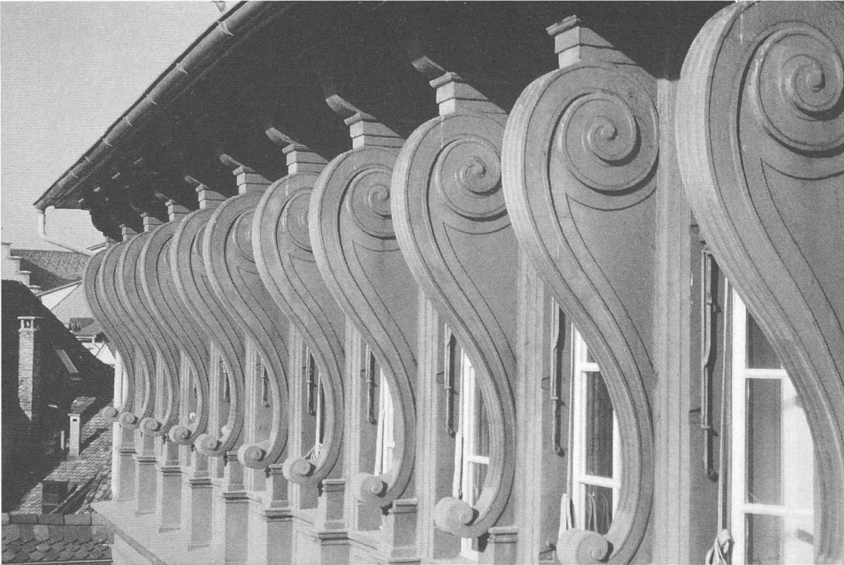
Abb. 35 «Spiesshof», Renaissancebau, Konsolenreihe des 3. Obergeschosses
